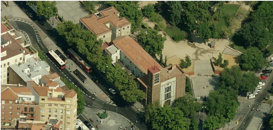
Ilustración 49. Vista desde el Sur Aspecto del conjunto después de la finalización del parque aledaño. La diferencia estructural entre el cuerpo de la Iglesia y las dependencias parroquiales es evidente, así como el extraño encaje de la fachada proyectada por Muñoz Monasterio.
