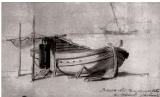
Fig. 11.- Barca del bou convertidas en viviendas
